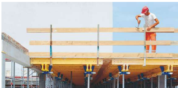
Figura 3.65: Caso d'uso «Protezione contro la caduta dall'alto» – parapetto in cantiere
